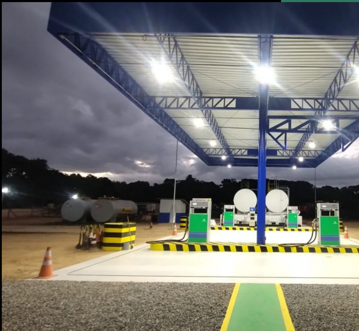
REFORMA DE POSTO DE COMBUSTÍVEL CLIENTE SUZANO PAPEL E CELULOSE
